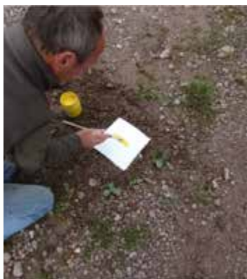
Repeindre une balise sur une borne enterrée
