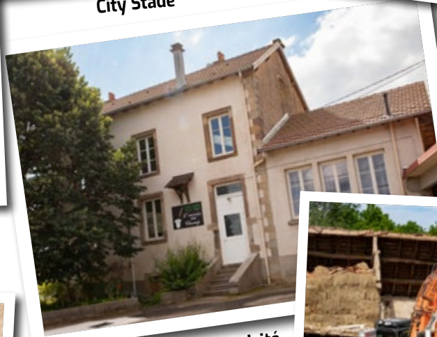
Encrier au champ - Electricité
