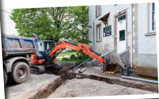
Mise aux normes assainissement Guménil
