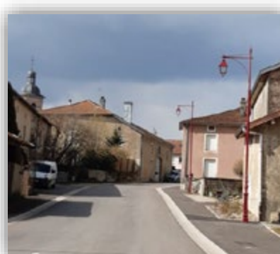
Enfouissement des réseaux à Sandaucourt
