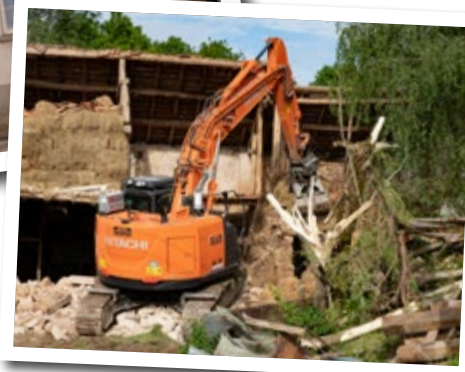
Démolition maison EVE rue du Noir Étang
