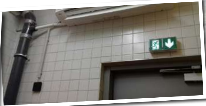
Changement de la climatisation du local poubelles alimentaires de la restauration scolaire
