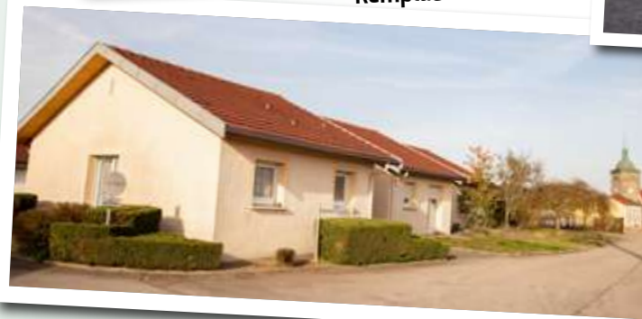
Résidence du fil d'Argent1 réfection des peintures des logements 4 et 5 et changement du revêtement de sol logement 4
