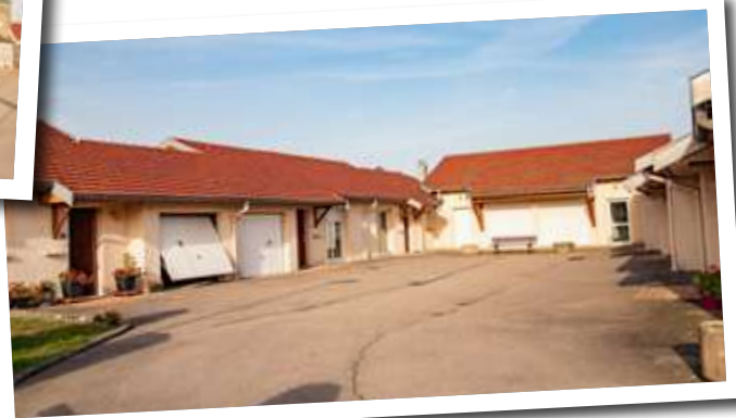
Résidence du fil D'Argent Remplacement des VMC des 6 logements
