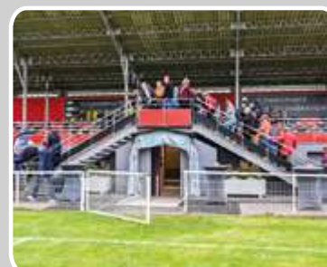
Stade du 13 ème Bataillon à Nomexy 09/2023 Rénovation de la tribune et des vestiaires
