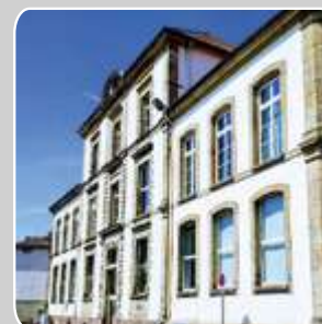
Faculté de Droit à Épinal Lancement des travaux de restructuration en vue d'accueillir en septembre 2024 une double licence droit-gestion.
