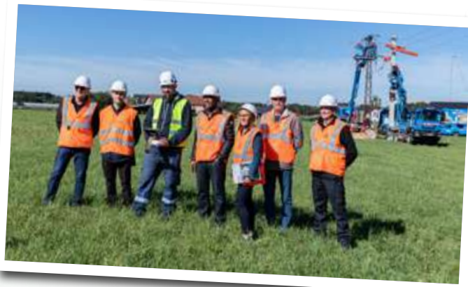
Invitation d'Enedis sur site pour changement d'un poteau sous tension d'une ligne HT
