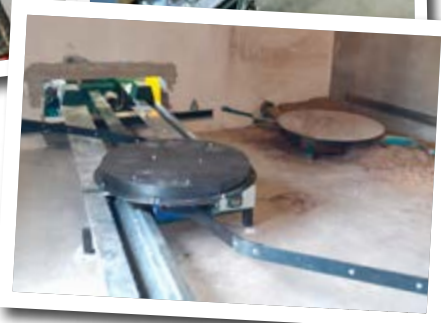
Raccordement et mise en service
