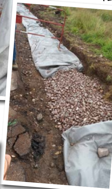
Tranchée remplie de grave drainante avec cloisonnements
