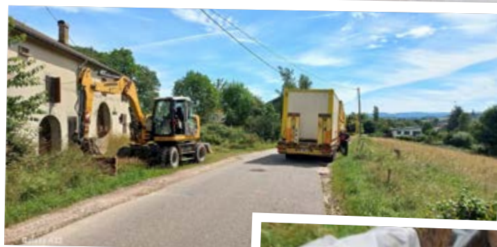
Installation de la base de vie Merci au riverain qui a laissé à disposition de l'entreprise la devanture de sa maison.
