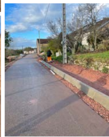
Tranchée remplie de grave drainante avec cloisonnements
