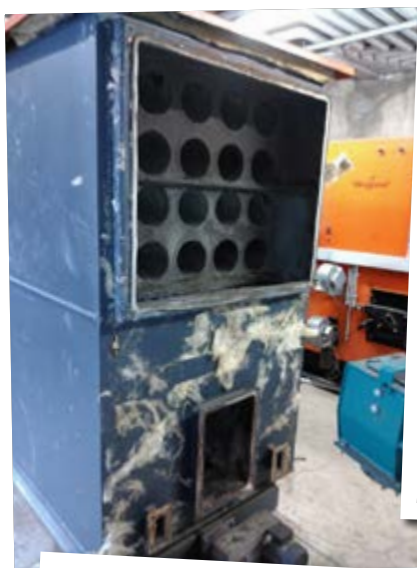
Démontage de la chaudière
