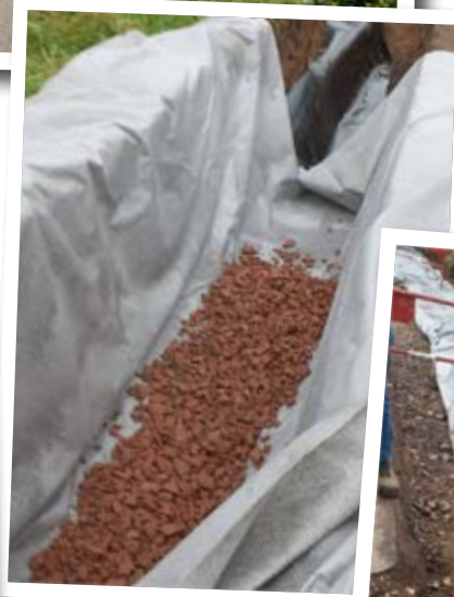
Tranchée d'infiltration Pose d'une géo-membrane latérale
