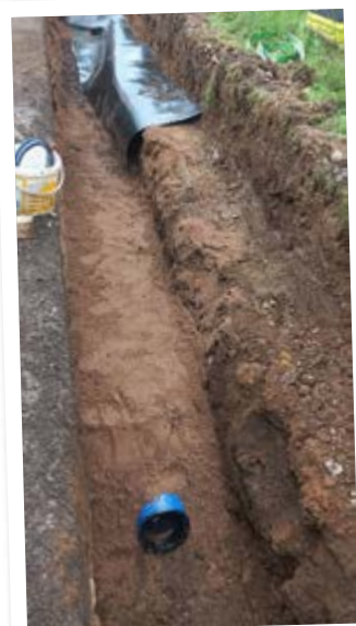
Canalisation d'eau potable en fond de fouille
