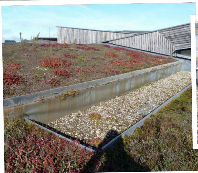
Remplacement partiel des grilles pare graviers de la toiture végétalisée du groupe scolaire
